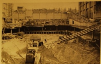
Fig. 23. — Vue d'ensemble de la construction prise du pied d'épave. On voit le bâtiment de la machine, à gauche et à droite, les « grilles » soutenant les poutres en bois. Cette vue montre l'extension de la fouille à l'intérieur d'un bassin périphérique des « murs extérieurs » et relatif par la proximité des « murs intérieurs ».
