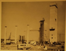
Fig. 19. — La tour ou la tête avant pendant la cons- truction. On voit ici le système de coffrage glis- sant qui a été em- ployé. À gauche trois des piliers destinés à suppor- ter le pont-canal.
