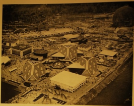
FIG. 10. — Vue aérienne d'un ensemble de pavillons très différents. Au centre, les trois pavillons jumelés, à plans hexagonaux, qui abritent les éléments d'exposition développant le thème : « L'Homme interroge l'Univers ». (À droite) : Agence, Pavillon, Olympiques, L'homme et son monde, Montréal, construction canadienne en construction, par les deux plus grandes entreprises de production d'électricité du Canada : l'Hydro-Québec et l'Hydro-Ontario.
