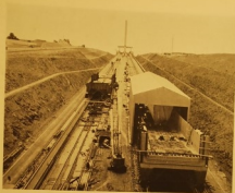
Fig. 17. — Vue générale du barrage. Le réservoir pendant les travaux de montage des bacs.
