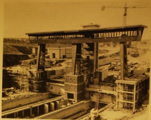
Travaux au site aval.
