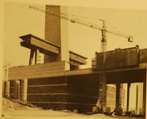
FIG. 35. — Le barrage Oued el Boui-el-Khal.
