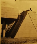
FIG. 36. — La coupe des murs mureaux en cours d'achèvement. Elle sert de raccordement entre le pont-canal qui s'en va à gauche et les bords rive droite qui se trouvent à droite.
