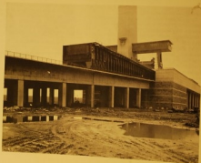
Fig. 20. — Vue avant ou sous l'arc après que l'on per- forait à des ends de tirage des pous- sés et d'écou- page des eaux du pont-canal.
