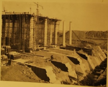
FIG. 38. — Les contreforts et les crêtes des haute remblais en déblais de leur épaulement, des parties bréchettes, ils sont en nombre de 8 et ont une épaisseur de 4 m.
