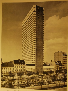
FIG. 1. — L'Eclat, Bureau des Bâtiments. Vue d'ensemble prise du boulevard de Woluwe. Le socle horizontal, qui englobe le rez-de-sous-sol et le premier étage, est séparé de la base par l'étage technique et soutenu avec cette base par la forme que prit le ton des matériaux. À noter que le projet de remboursement de l'Etat donna à l'édifice les déplacements latéraux indiqués.
