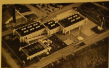
Fig. 2. — Le Pavillon du Japon, situé sur la rive Nord de l'île d'Atomium-Belgique, face au port de Bruxelles, a été construit au rythme de l'Exposition. Les quatre modules qui composent cet ensemble ont été construits sans des poutres en béton précontraint. Au pied de ce pavillon un jardin à l'orientale, où le thé est servi à la japonaise.
