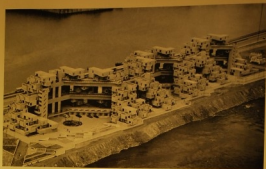
Fig. 10. — L'ensemble constructif, « Blocs II » avec ses groupes de cellules d'habitation indépendantes : laboratoires, fasciade au rive gauche du déversoir. Chacune de ces 100 cellules comprend un appartement d'une à quatre pièces d'accès par un jardin suspendu aérien. (Architectes associés : Moshe Safdie et David, Barrett, Boudin, Ingénieur-conseil : Kiewit Inc., Ingénieurs-Consultants associés : Mandl, Rayburn, Emswiler, Volkm.) Lors de l'érection de l'Équipement est installé « échafaudage » avec unités de l'Équipement porte. Il a été envisagé également de mettre à la disposition de cellules à l'Équipement porte. Il a été envisagé également de mettre à la disposition de cellules à l'Équipement porte. Il a été envisagé également de mettre à la disposition de cellules à l'Équipement porte.
