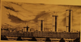
Fig. 32. — Façade montrant les nervures mises en œuvre dans la rapidité d'élévation des locaux pour l'emploi des coffrages glissants (les 3 tours ont été posées successivement les 12 et 13 septembre et les 5, 11 et 18 octobre).
