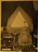
Fig. 36. — La Gyroton, la plus sensationnelle des attractions d'Expo 67 dans le secteur de la Ronde : deux structures métalliques, dont la plus grande, de forme pyramidale, constituée de profils d'aluminium assemblée par réseau triangulé, mesure 62 m de côté et 65 m de hauteur. Les passages qui traversent plus de 100 m de hauteur de ce gigantesque « fer à cheval » relient un temps d'attente à l'autre avant d'être plongés dans les entrailles de la terre. (Architecte : Sam Roney, Londres, auteur du projet, avec la collaboration de G. Pyrahon, Londres.) 4 500 t de profils d'aluminium ont été fournis par l'Alcan (Aluminium Company of Canada).
