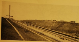
FIG. 1. — Vue d'ensemble du plan incliné de Ronquières, du premier plan, la partie enterrée, avec la conduite forcée; au second plan, à gauche, la partie aérienne et la tête amont avec sa tour d'observation de 200 m de hauteur.
