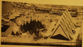
FIG. 25. — Les pavillons construits en la section sous extension (à droite), haut de 25 m, large de 20,2 m, long de 47 m, à ossature apparente d'une conception simplifiée et des panneaux en fibre à verre et en verre courbés (à gauche), hautement de ces quatre grandes pyramides en matière translucide, de hauteurs différentes (jusqu'à 25 m), symbolisant l'élévation fait simultanément et dominant les résidents à l'intérieur du pavillon. Il est facile aux visiteurs de s'imprégner de l'atmosphère qui règne dans une soirée, car ils y sont conduits à parcourir le cycle de l'élaboration de l'acier sur des modèles en vraie grandeur. (Architectes, ingénieurs: Mathers et Chalmers, Toronto, associés par Irving Conn, Corp. Ltd., Toronto; Papier: projet de Knudsen et Wismersdorf Ltd., Montréal, réalisé par Peter H. Arre, Montréal, sous le patronage de C. A. Dubois, Montréal.)
