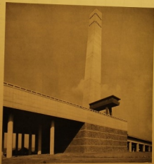
FIG. 21. — Vue de la tite amont et de la tour, à gauche le pont-canal et à droite le plan incliné (partie amont).
