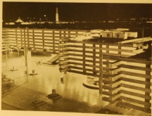
Fig. 3. — Vue rapprochée du Pavillon japonais. On voit bien ici le détail de la structure composée de poutres en béton précontraint, coulées au Japon, assemblées une par une et solidarisées sur place après un long parcours maritime. (Architecte principal : Tachikawa Osamu, Tokyo; architectes associés : Itochiguchi, Iwasaki, Kishida, Nishida, Morioka.)
