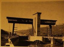
FIG. 7. — Vue au pontique ou au-dessus des pontons en sa tête aval. À l'avant, plus le bief avec ses murs d'arrêt et au centre les deux d'ânes. Cette vue a été prise le milieu de la mise en eau du bief aval.
