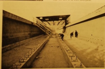
FIG. 13. — Le mur radial s'élevé pendant le séchage et le battage des bétons dans lesquelles sont installés les rails de roulement et de guidage des bacs et de leurs contrepoids.
