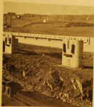
FIG. 12 (réduction). — Ecran, avec ses ailes au sud et au nord, au fond le mur d'eau.
