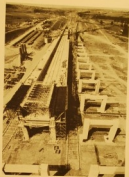
FIG. 13. — Le mur radial s'élevé pendant le séchage et le battage des bétons dans lesquelles sont installés les rails de roulement et de guidage des bacs et de leurs contrepoids.
