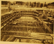
Fig. 24. — Vue intérieure de la structure, du pied, de la dalle qui répartit la charge des étages sur une surface de près de 1 000 m².
