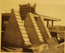
Fig. 39. — La coupe sur une machine montre en effet que la construction des contreforts tend de se terminer et que commencent la formation des dalles.
