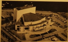
FIG. 34. — Le théâtre Expo, construit en bois de hêtre. La salle de spectacle comprend 2 000 fauteuils d'orchestre et 650 fauteuils de balcon. Son cadre est entièrement intégralement de bois massifiés. La plate-forme mesure 30,5 m sur 32,5 m et 22 m de hauteur; le sol de la scène est long de 24 m et haut de 3,5 m. (Architectes : P. Warren, J. B. et J. C. Pearson, R. Dunlop.)
