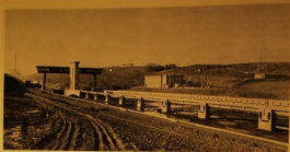
Plat. III. — Vue d'ensemble du plan second ou longitudinal de la zone alvéolaire. Au premier plan les alvéoles d'ibée au milieu du bief aval, sur la rive opposée la zone d'ibée et de l'acrotrophie, la centrale hydroélectrique. Au second plan, le perron, le four de la ibée aval, avec le pontique du manège des postes, puis le plan incliné, et la zone aval, avec le ponton d'ibée de la centrale.
