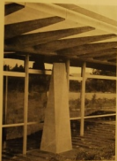
FIG. 12. — Un des poteaux sur lequel reposent, par des poutres multiples en béton précontraint, la masse de l'ouvrage adossé au talus. À remarquer l'ajustement de forme précis du bois en haut et par ses arêtes chanfreinées en T également, en tête du pilier, la coiffe métallique qui sert d'appui et d'articulation à la poutre d'assise correspondante.
