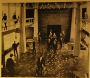
Fig. 19. — Vue intérieure du hall reliant l'immeuble administratif à la salle de Conseil exécutif. Le sol est en dalles de marbre. Les murs extérieurs des passerelles et les cloisons de base sont en aluminium. Les piliers sont isolés contre le dégivrage.
