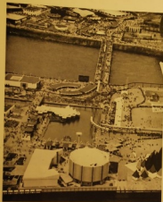
Fig. 10. — La passerelle en Grouville reliant le chenal Le Miran et reliant les deux îles à l'aval de la hauteur des pontons des Ecluse-1 et de l'Écluse 2, au premier plan, au centre, le ponton de la « Canotière Pierre Guichard ».
