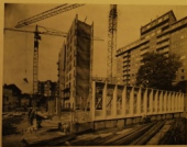
FIG. 17. — Avancement des travaux le 15 novembre 1955. Remarquons la rapidité avec laquelle on a pu commencer la pose des éléments préfabriqués de la façade latérale au sud-est.
