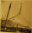
Fig. 31 (à droite). — Vue totale au point de vue de la conception du prototype allemand : les câbles fixes de tension (treillis analogique à une voile de voile) sur un plan d'acier qui lui sert de support. La structure d'essai-prototype ainsi réalisée est d'une exceptionnelle légèreté : il pèse plus de 2,2 kg par mètre courant.
