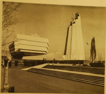
Fig. 28. — Vue générale de l'un des édifices construits en préfabriqués de la Grande-Breta- gne. L'imposant Edison Arch, en acier chromé-nickel, qui surmonte la tour centralisée, monte jusqu'à une hauteur de 100 m., constituant l'un des points dominants de l'île Notre-Dame. On peut voir dans les figes suivantes de l'ensemble.
