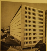
FIG. 36. — Façade extérieure. Façade des mâtures (éléments que la façade principale, stabilisée contre deux montants en béton armé, laisse voir en place et laqué apparent.
