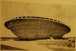
FIG. 1. — L'aspect extérieur de la salle couverte, très grande, dont la coupe en coupe mince de béton a un aspect particulièrement beau par rapport aux autres photos, mais aussi par l'originalité et l'élégance par le jeu des dispositions et des motifs des planchers de coffrage.
