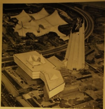
Fig. 27. — Vue d'ensemble des constructions en aluminium au pavillon britannique, dominées par la tour de forme tronconique haute de 62 m, ornée à droite : structure métallique, habillage par plaques d'aluminium sur lesquelles a été projetée l'effigie. L'absence de fondre souligne l'impression de substrat poreux sur un site symbolique rappelant le caractère insulaire du peuple britannique (Architectes : Sir Basil Spence, Birmingham et Collins, Londres) (Musée, Lonsayrie, Stone, Canada). À gauche, à l'arrière-plan, le pavillon de l'Allemagne fédérale.
