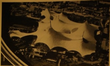
Fig. 30. — La version de la Hélice-vent Filiale d'Allemagne, se compose au total (100 x 30 m) est couverte par un treillis en acier auquel est suspendue une mince voile transparent de 3,6 mm d'épaisseur, ce qui lui donne l'appart d'un filet de pêche depuis ses deux bouts de 30,0 m. (Architecte : Peter Otto, Berlin.)
