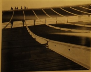
FIG. 19. — Mise en évidence au moyen photographique de la courbure, obtenue simplement par la jointe rigide des câbles dont la longueur totale correspond à la courbure.
