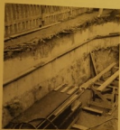
Fig. 9. — Vue sur sous-sol, face l'avenue d'Anvers.
