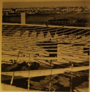
Fig. 17. — L'ensemble du la terrain lors de la pose des deux nappes de câbles autoadhésifs, avant couverture.
