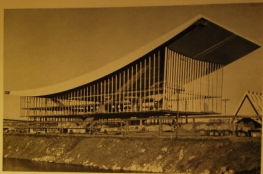
Fig. 35. — La pyramide de l'U.R.S.S. est couverte par une gigantesque toiture cantilevée mesurant en plan 67 m x 107 m. À travers des quatre immenses trappes de verre, d'un seul tenant, de ses façades transparents la structure métallique fine et fluide qui supporte la toiture et les plates-formes d'exposition. La magnifique mosaïque a été conçue par une équipe d'architectes soviétiques et d'ingénieurs allemands et réalisés avec le concours des bureaux des ingénieurs-constructeurs allemands Bräunchen, Berlin, Leipzig.
