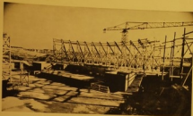
Fig. 9. — Mise en place de l'échafaudage en bois pour la construction de la coque, destiné à supporter le coffrage de la construction supérieure.
