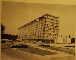
FIG. 3. — Vue du département de la région Nord et service administration de l'O.M.S. À droite de l'annexe administrative, le bâtiment antique de la salle du Conseil Exécutif.
