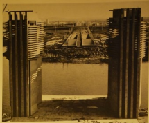
FIG. 8. — La nouvelle tour de ventilation. Au premier plan deux des quatre tours aspirant l'air frais qui est ensuite repoussé dans le tube central d'où il est distribué aux tubes de circulation aux bords pour dégager. L'air est comprimé par les centrifuges et par les tours de ventilation dans les conduits de ventilation.
