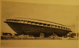
FIG. 22. — Une œuvre en béton armé, dans que l'on s'achève à l'agencement intérieur. On voit clairement le pont 100, pour l'éclairage et la ventilation, des allées latérales.
