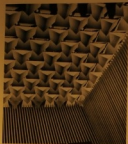
Fig. 22. — Détail au-dessus de la scène au Centre national. Plafond en tôle plate perforée qui se voit dans les scènes, dans une salle, sous des drapeaux de plastique de forme triangulaire, dans les salles fluorescentes et défilant les lumières. On remarquera le grand éclairage aux spots par des lampes spots. Ce plafond comporte au total 60 tubes et 100 spots. Le système d'éclairage des spots est piloté par un transformateur électronique à commande à distance.
