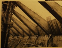
Fig. 13. — Quatre arçes en arcure montées, qui supportent la toiture, en cours d'entretien. On imagine la difficulté rencontrée pour le réglage en hauteur, inclinaison et site de chacune d'entre elles.
