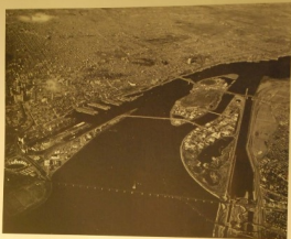
Fig. 1. — Vue aérienne de sites en construction, aménagés sur les deux îles du Saint-Laurent, l'île-Duhamel au premier plan, l'île-McGill au second plan et à gauche, sur la rive Montreuil, la « Cité du Fleuve ». À l'arrière-plan, la ville de Montréal.
