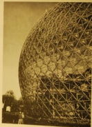
FIG. 40. — Détail de la construction en verre transparent. Le pavillon en plastique qui recouvre son double réseau triangulé (triangles et hexagones) a été réalisé d'un matériau transparent, rendu réfléchissant par une mince pellicule métallique. (Constructeurs métalliques : Simpson Gumpertz et Heger.)
