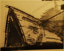
Fig. 8 et 9. — Voûtes principales et une des salles côtées pendant la construction. Les coquilles, tempora- irement, soutiennent les poutres métalliques en position, en plus et à mesure de leur levage, les éléments des coquilles, jusqu'à ce qu'ils puissent s'épanouir sur tous les angles.
