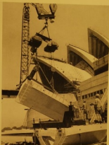
FIG. 15. — Pose d'un élément de toiture en béton préfabriqué.
