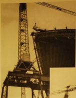
FIG. 15 et 16. — Vues montrant la mise en place et montage successif des caissons en acier des caissons servant à la construction.
