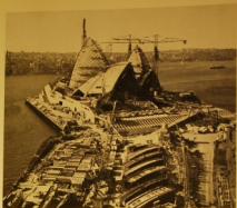
Fig. 6. — Les éléments du toit sont montés en position et soulevés jusqu'à occuper leur position finale (2,8 ha) de la plate-forme par laquelle l'ouvrage est édifié. Les éléments préfabriqués en béton, au premier plan, ont été coulés sur place.
