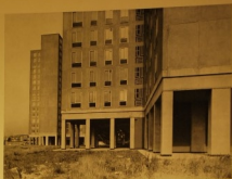
Fig. 15. — Les axes menés et la coupe I. Le site est pris du sud-ouest (à l'arrière du terrain). À l'avant-plan, les ailes 2 et 3 du bloc 2, au fond, les ailes 2 et 3 du bloc 1.
