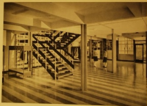
FIG. 13. — Le bois s'harmonise avec l'escalier construisant avec les charpentes atténuées à l'étage. Le bois est posé dans la direction Nord-Sud. A droite, module construisant vers le hall de l'entrée principale. Toute la répétition des colonnes et le hall assurent de l'unité.
