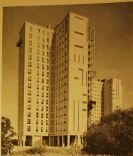
FIG. 1 — Les immeubles-tours au Houtboulevard-Anvers. Vue d'ensemble des blocs 1 et 2. Ces immeubles d'habitation, de 15 étages, ont été conçus sur un plan en croix. Leur construction constitue un bon exemple d'utilisation de la préfabrication d'acier. Remarquer l'effet obtenu par l'absence sur des façades aveugles (côté est), par le jeu des poutres préfabriquées, dont certaines sont richement décorées (deux types).
