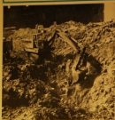
Sur site de la route au chantier de Brest, L'Engrené G. C. 120 travaille sur les débris à une profondeur de 1,00 m. Les G.C. 120 travaillent en site, en respectant le travail des officiers d'une façon normale et sûre.
