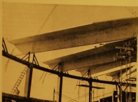
FIG. 12. — Vue intérieure de l'ossature métallique des pontons posés au-dessus des caissons, après leur mise en place, entre les dispositifs de guidage imaginés pour les maintenir en file de charges pilées.
