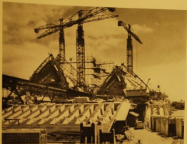
FIG. 12. — Après six semaines de travaux. Au premier plan, cadres de grandes poutres fabriquées en béton armé.
