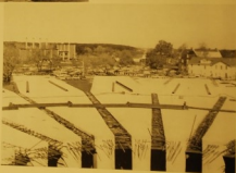
FIG. 6. — Vue au développement du béton (câbles en noir) à l'extrémité de la poutre en U, d'où émergent les deux tendons de précontrainte. Les câbles sont défilés au moment du recouvrement à l'extrémité central en acier.
