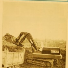
Equipe en charge 1961, la D. C. 100 des Engins POCLOIN travaille au grand terrassement du station de la Nouvelle Université de Liège.
